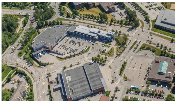
Kuva 2 Suunnittelualueen viistoilmakuva tilanteesta ennen uuden linja-autoaseman toteuttamista
